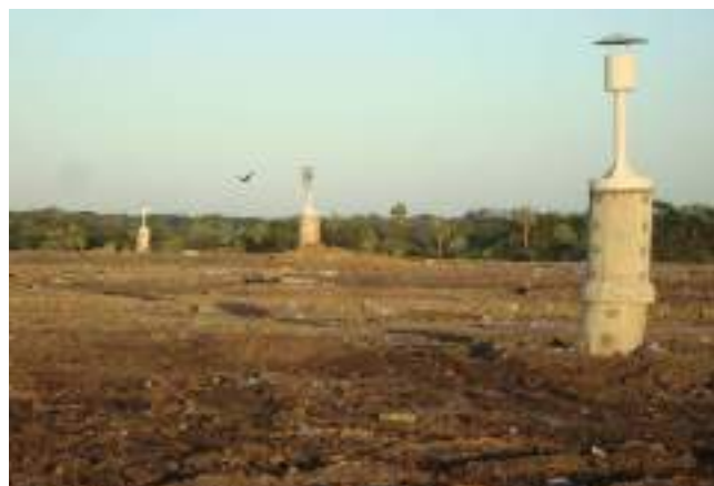
Foto 7.109: Sistema de drenagem de gases do ASMOC. Fonte: Ecofor Ambiental, 2016.
