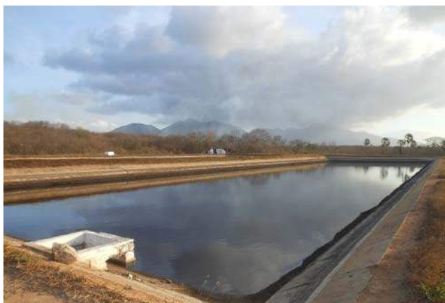
Foto 7.108 Lagoas de estabilização integrante do sistema de tratamento do chorume do ASMOC. Fonte: Ecofor Ambiental, 2016
