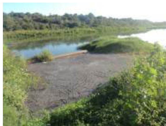
Foto 7.123: Pecém – Lagoa de estabilização de esgotos com presença de lodo sobrenadante, denotando sinais de falta de manutenção. Fonte: Engesoft, 2016.
